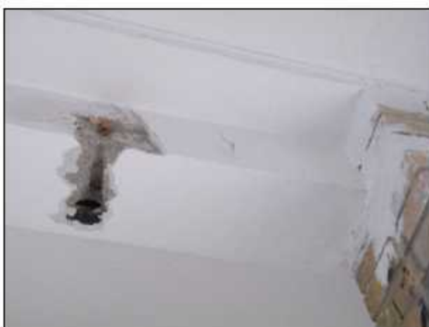
Figura 9. Sondaggi sui cordoli al primo livello
