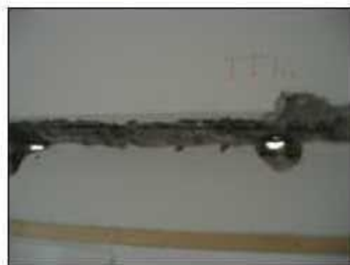
Figura 12. Sondaggi su travi al primo livello
